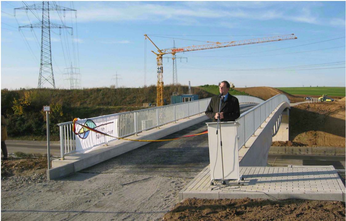
Einweihung der Brücke über die A 81 auf Freiburger Gemarkung am 10.11.2006
